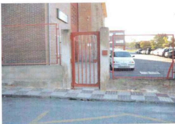
Fig. 8 Acceso peatonal calle Blas infante
