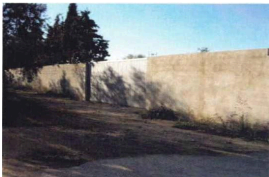
Fig. 7 Portón Instituto calle Torrijos
